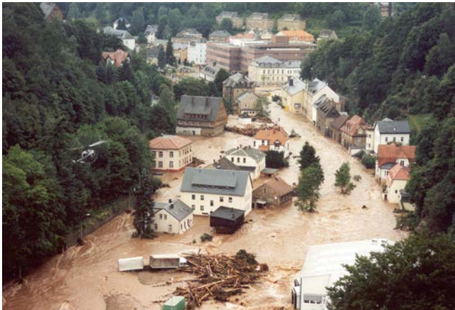
Durch das Jahrhunderthochwasser von 2002 kam es auch in Ostdeutschland zu schweren Überflutungen. Für die SUG bedeuteten sie einen Totalschaden des erst 1999 gegründeten Unternehmens. Foto: Stefan Höhnel
